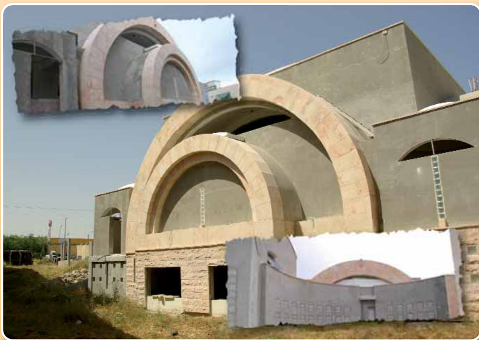
Boogvormen in de muren van het nieuwe complex
